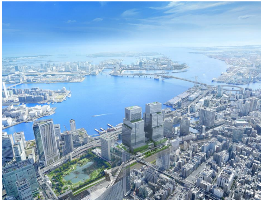
【2030年度に全体竣工する「芝浦プロジェクト」】
