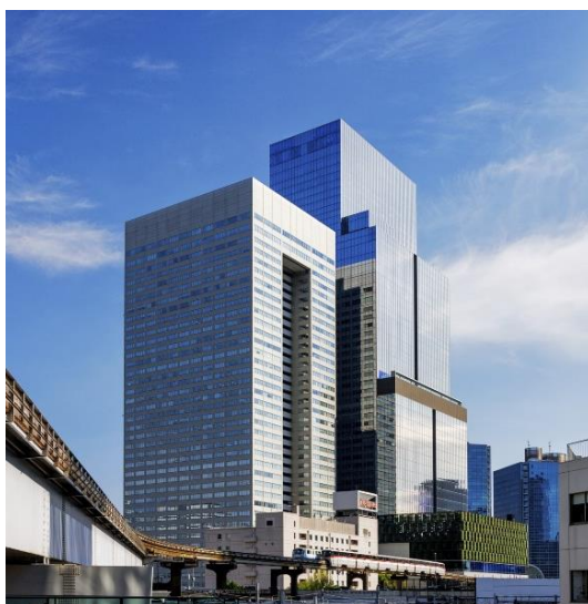
浜松町ビルディング（左手前）・東芝浜松町ビル（中央手前）・BLUE FRONT SHIBAURA TOWER S（奥）
