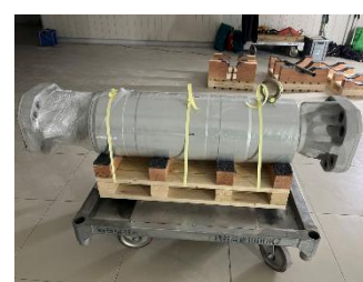
制振ダンパー取り外し後、養生
