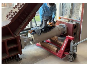
制振ダンパー設置状況(取外しの器具設置)
